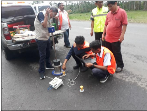
Gambar 1. LWD Pusjatan Dalam Pengoperasian
